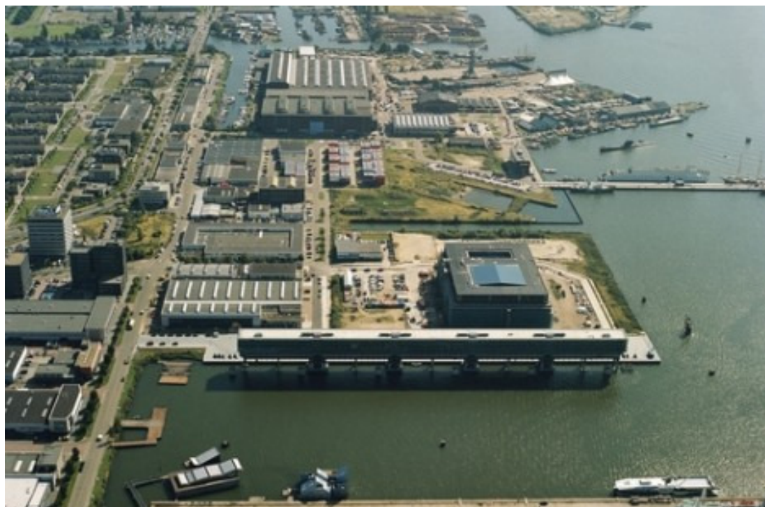
A teljes NDSM kikötő felülnézetből. Előtérben a média cégek székházai, mögötte középen közpark és a kollégiumi épületek, a háttérben a nagy hajógyári csarnok. Forrás: www.ndsm.nl
